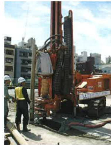
ボアホール方式 施工:大林組(三菱マテリアルテクノ)
