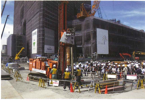
東京スカイツリー地域熱供給（ソニックドリル工法）
