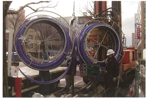
ダブルUチューブ設置状況（歩道融雪用）
