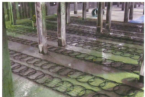
鉄道トンネル下床版への敷設事例（駅待合室空調用）
